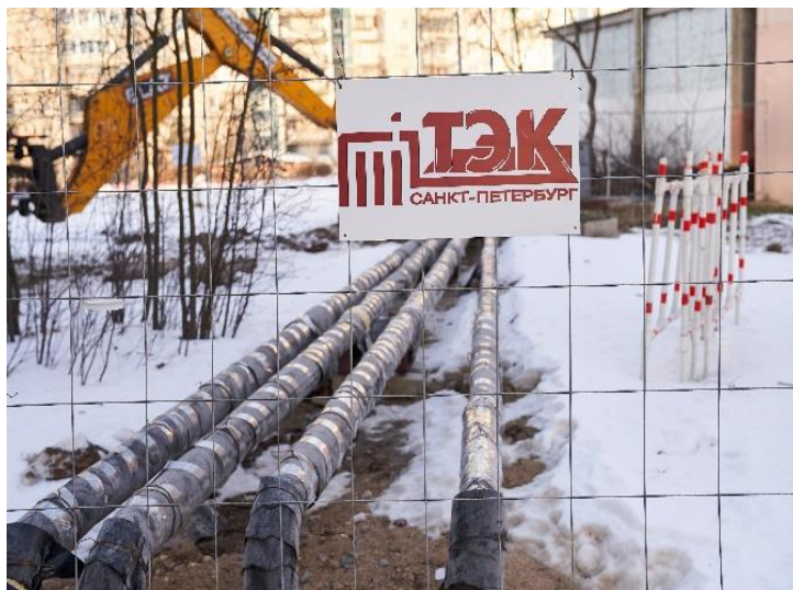
Завершение строительно-монтажных работ по реконструкции магистральной тепловой сети по ул. Маршала Новикова (проезд 5) от Автобусной ул. до ТК-5 в нежилой зоне Коломаги (Ду 500 мм, L=2250,9 м труб)
