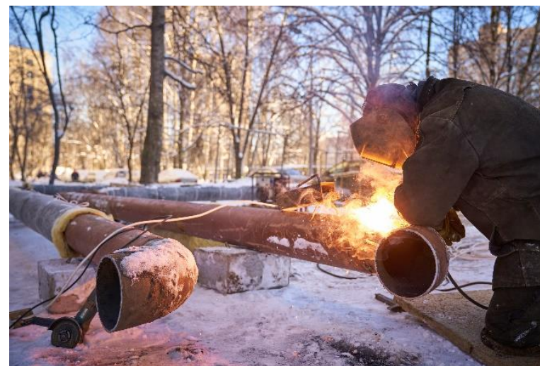
Выполнение строительно-монтажных работ по реконструкции тепловых сетей по адресу: г. Кронштадт, квартал В, ул. К. Либкнехта, д. 25, д. 27, ул. Рошаля, д. 10, Советская ул., д. 33; ул. К. Либкнехта, д. 17, д. 30, Советская ул., д. 25; ул. К. Либкнехта, д.15Б, д.15А, д. 24, Советская ул., д. 19, д. 15 (Ду 50-150мм L=706,35 м труб)
