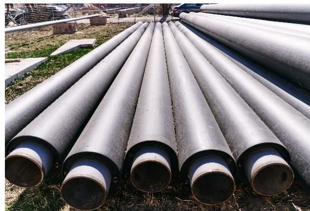
Реконструкция тепловой сети по Брантовской дороге от ТК-8 у Якорной ул. до ТК-10 у Магнитогорской ул. (Ду 800 мм L = 386 м труб)
