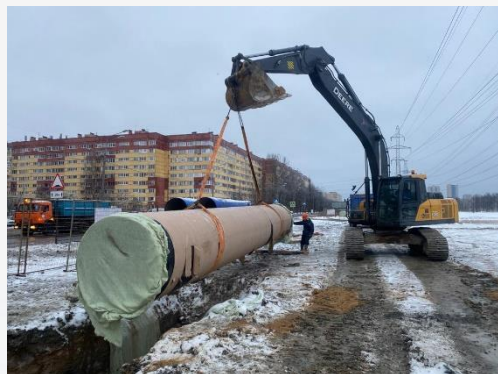
Реконструкция водопроводной сети по адресу: Петергофское шоссе от ул. Доблести до пр. Маршала Жукова ДУ 1000-1200
