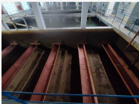
Ремонт скорых фильтров и здания очистных сооружений ГВС по адресу: ул. Кавалергардская, д. 42, лит АШ
