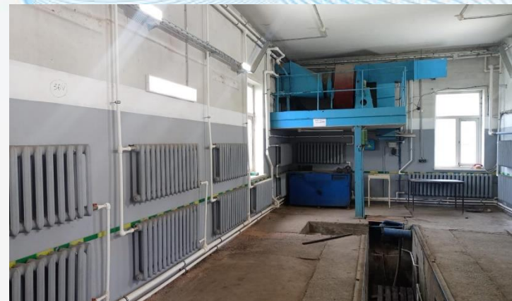
Ремонт систем отопления зданий филиала "Водоснабжение Санкт-Петербурга"
