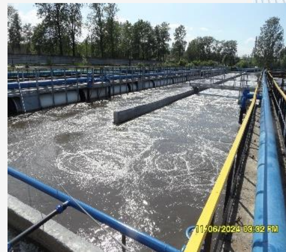
Капитальный ремонт аэротенка (2-ой очереди секции №2) по адресу: г. Санкт-Петербург, г. Колпино, ул. Севастьянова, д. 20, литера АБ
