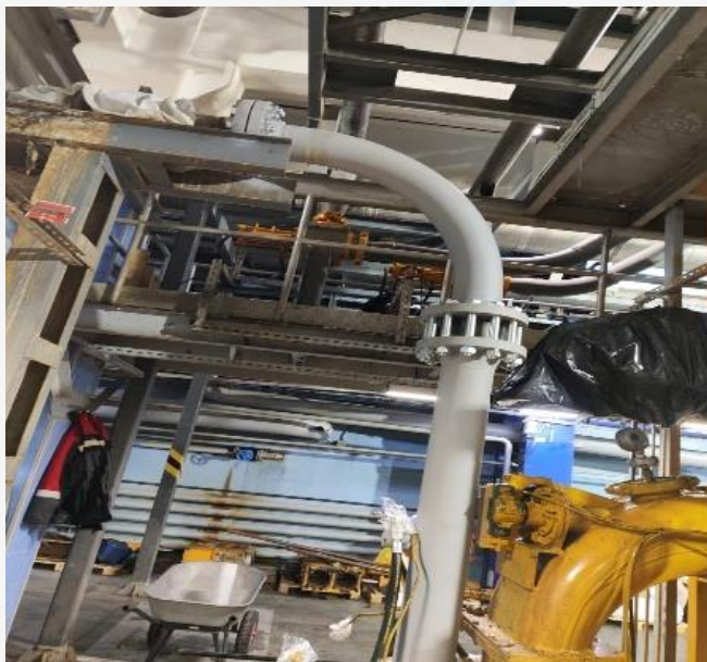
Ремонт системы транспортировки обезвоженного осадка цеха обезвоживания, с заменой задвижек и трубопроводов по адресу: Санкт-Петербург, Коннолахтинский пр. д.12 к.2, лит. Д.
