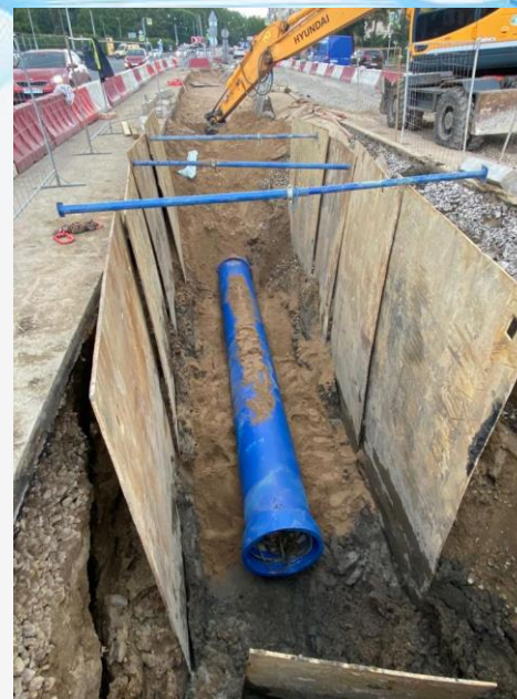
Реконструкция водопроводной сети Д=300-900 мм с примыкающими домовыми вводами по адресу пр. Стачек на участке от Промышленной улицы до улицы Трефолева, площадь Стачек
