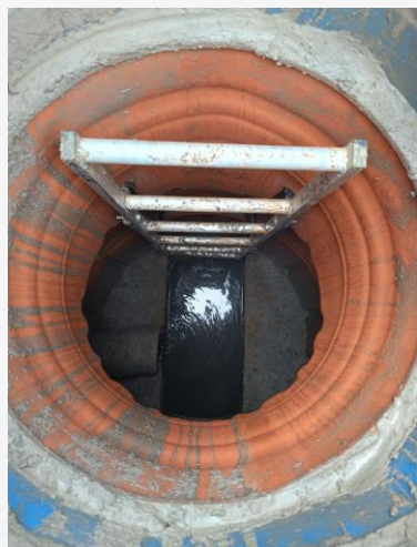
Выполнение работ по ремонту колодцев на канализационных сетях
