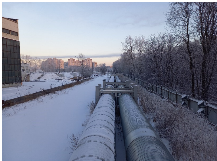
Реконструкция магистральной тепловой сети от 2- ой Правобережной котельной по адресу: г. СПб, ул. Ванеева, д.3 до УЗ- 3 (Ди 800 мм L = 632 м труб)
