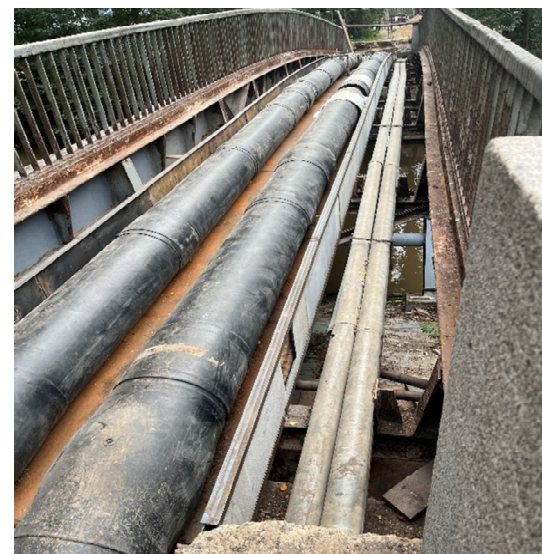
Реконструкция магистральной тепловой сети от 2- ой Правобережной котельной по адресу: г. СПб, ул. Ванеева, д.3 до УЗ- 3 (Ди 800 мм L = 632 м труб)
