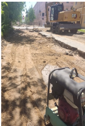
Реконструкция магистральной тепловой сети по адресу: г. Кронштадт, Посадская ул. от ТК-8(ТК-9) до ТК-21а на ул. Восстания (Ду 150-600 мм L – 520 м труб)
