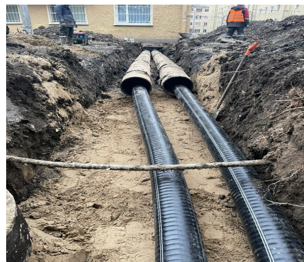
Реконструкция тепловых сетей в квартале 134-140 (часть) (Ди 50-200мм L= 7 956 м труб)
