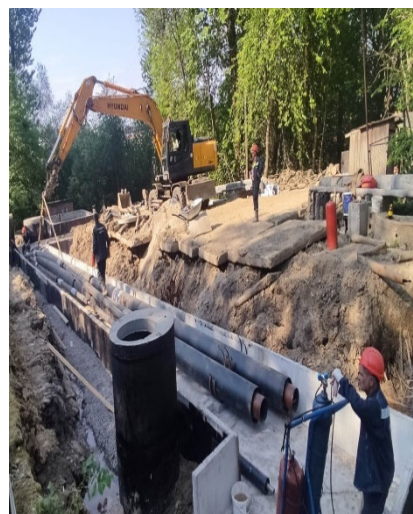
Реконструкция тепловых сетей от ведомственной котельной НАО «СВЕЗА Усть-Ижора» по адресу: пос. Понтонный, ул. Фанерная, д. 5 (Ду 50-250 мм L- 2 143 м труб)
